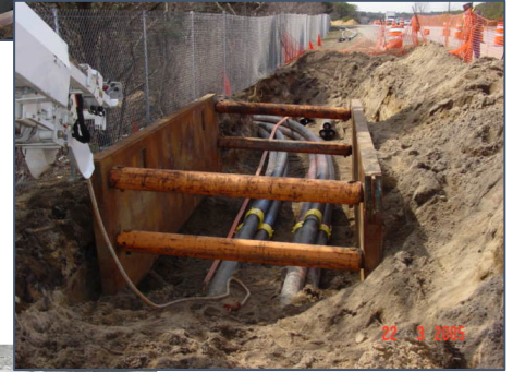
Conduit Installation
